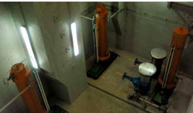
túneles como las compuertas de seguridad, que se encontraban gravemente dañadas por el paso del tiempo y por las extremas condiciones de servicio a la que estos conductos se han visto sometidos. Estos conductos tienen una longitud aproximada de 500 m, de los cuales unos 100 se sitúan aguas arriba de las compuertas y los 400 restantes hacia aguas abajo hasta la restitución en el río Cinca.
