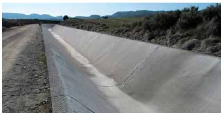
la margen izquierda y en coincidencia con las obras de drenaje transversal que se habían limpiado; la limpieza del interior de la acequia y de las obras de drenaje transversal, la mejora del desagüe de las obras de drenaje transversal, la reparación de fisuras y juntas en acueductos y cajeros de la acequia y la reposición de servicios.
