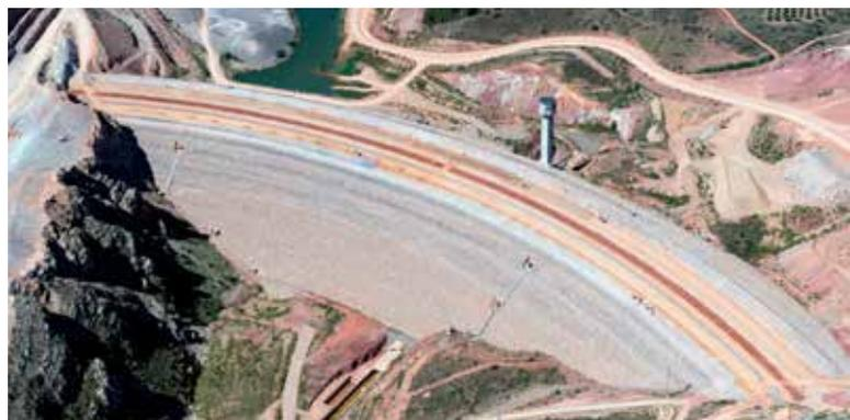
cimientos y 793,84 m de longitud de coronación, situada en el río Grío. La capacidad del embalse es de 103,3 hm<sup>3</sup>. Cuenta con un aliviadero, en la margen derecha, de labio fijo con tres vanos de 12,00 m cada uno y capacidad de desagüe de 472,00 m<sup>3</sup>/s a máximo nivel extraordinario.
