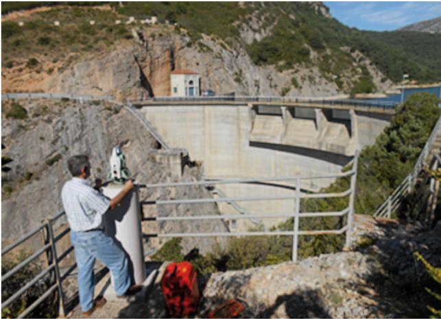
Control de movimientos verticales en presa de Materiales sueltos.
