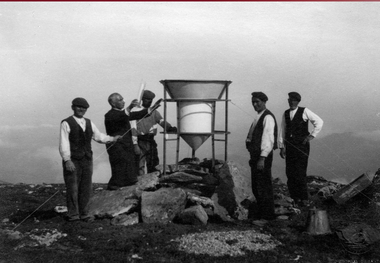
Instalación y bendición de un Pluviómetro Totalizador en los Pirineos. Años 30.
