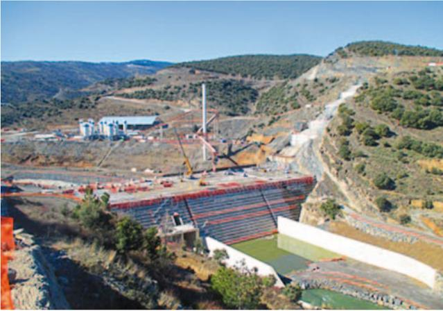
Hormigonado del cuerpo de presa visto aguas abajo.
