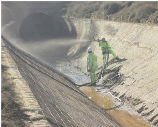
**OBRAS DE ESTABILIZACIÓN DE UN TALUD DEL POLÍGONO INDUSTRIAL DE AOIZ QUE AFECTA AL TRAMO 0 DEL CANAL DE NAVARRA, EN EL Pk. 0+800. T.M DE AOIZ. (NAVARRA)**
