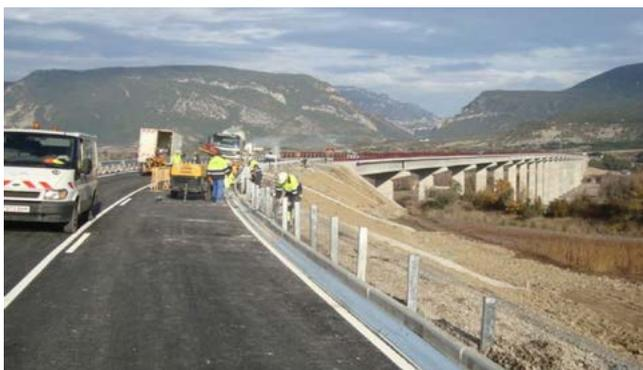
dos aceras de 1,40 m que incorporan barandilla y barreira de seguridad. El tablero consta de veinticuatro vanos de vigas prefabricadas postensadas de longitud variable entre 37 m y 47 m de luz y 2,35 m de canto. Las vigas apoyan sobre estribos de hormigón armado "in situ" y dinteles de hormigón pretensado, empotrados en fustes de sección rectangular aligerado de 4,0x3,0x0,4 m.
