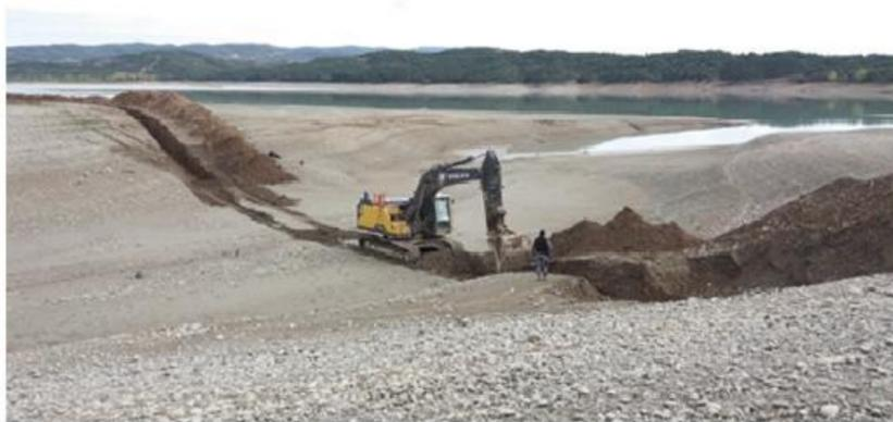
Las obras tienen por objeto la instalación de un equipo de bombeo desmontable en la presa del Embalse de Barasona y una tubería de conducción hasta el depósito actual de abastecimiento a La Puebla de Castro, que elimine los problemas actuales de abastecimiento que sufre esta localidad cuando el nivel del embalse está bajo, situación que condiciona la normal explotación del embalse.
