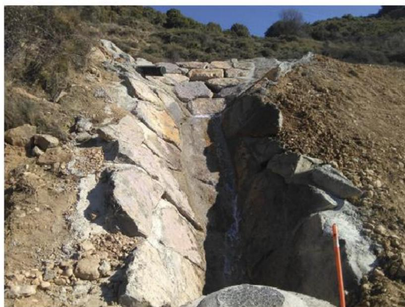
Durante la ejecución de las obras de drenaje para estabilizar el deslizamiento I-13 en el vaso del embalse de Montearagón, se produjeron unos movimientos de terreno saturado que afectaban de manera importante a la seguridad de dichas obras por lo que se resolvió declarar de emergencia unas obras tendentes a asegurar la estabilidad del terreno y dar la total seguridad a los trabajadores que tienen que realizar las excavaciones, entibaciones y colocación de los drenajes.
