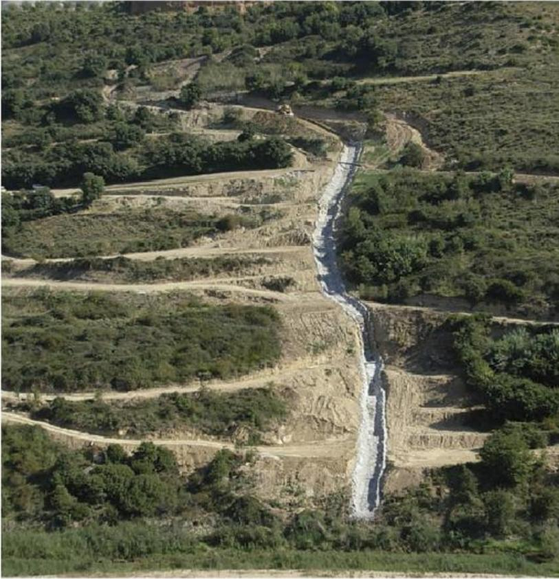
mm en zanja, 79,30 m<sup>3</sup> de escollera concertada, 2.138 m<sup>3</sup> de excavación en zanja para realizar dos drenes franceses rellenos con 1.405 m<sup>3</sup> de material granular formado por cantos rodados de diámetro 40-110 mm y realizar 15.000 m<sup>3</sup> en excavaciones en desmontes con su transporte a vertedero.
