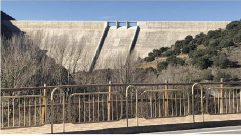
El proyecto define la construcción de una presa del tipo gravedad, de hormigón compactado de planta recta, de 103,12 m, de altura sobre cimientos, 375,6 m, de longitud de coronación y 717.592 m<sup>3</sup> de volumen de hormigón. La capacidad del embalse útil es de 46,5 hm<sup>3</sup> y tiene un aliviadero central de labio fijo con capacidad de desagüe de 877,20 m<sup>3</sup>/sg. Se incluye la variante de la carretera LR-115 de 6.557 m, de longitud.
