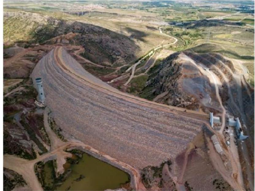
en ambos paramentos, con 82,58 m de altura sobre cimientos y 793,84 m de longitud de coronación, situada en el río Grío. La capacidad del embalse es de 103,3 hm<sup>3</sup>. Cuenta con un aliviadero, en margen derecha, de labio fijo con tres vanos de 12,00 m cada uno y capacidad de desagües de 472,00 m<sup>3</sup>/sg a máximo nivel extraordinario.
