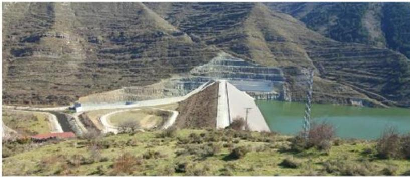
El proyecto comprende la construcción de una presa de materiales sueltos con pantalla asfáltica como elemento impermeable. Es de planta recta con una longitud de coronación de 356,35 m, y una altura sobre cimientos de 45,6 m. El volumen de materiales asciende a 885.514 m<sup>3</sup>. La capacidad de embalse útil es de 7,1 hm<sup>3</sup> y posee un aliviadero lateral de labio fijo. En las obra se incluye la variante de la carretera LR-250 de 2.700 m, de longitud.
